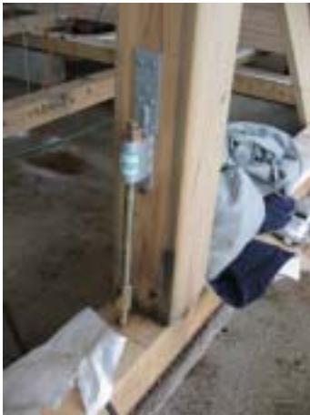
接合金物の品質 柱脚金物
