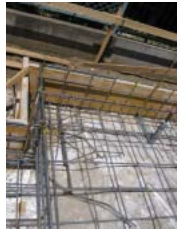
エコキュート用給水管
