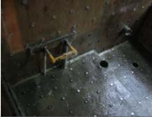
浴室FRP防水
