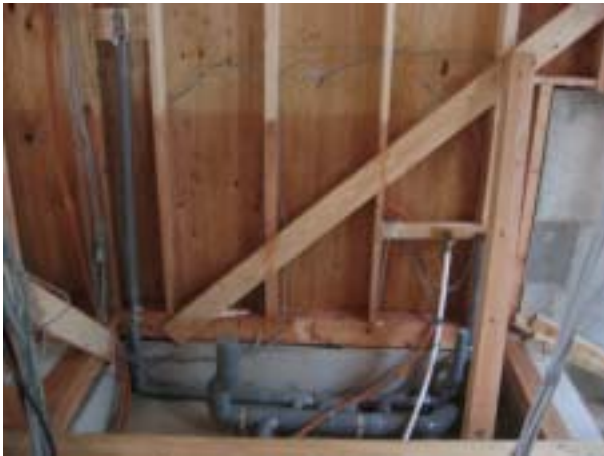
1階配管 左/脱衣室 右/洗面
