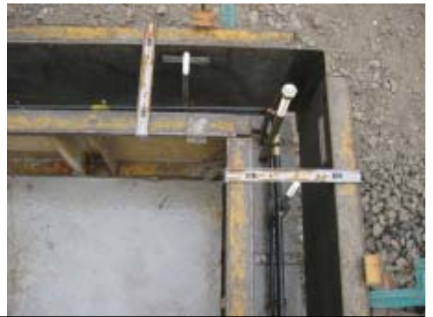
ホルダの金物 アンカボルト位置
