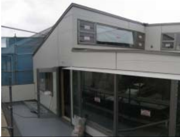
左/ 2階南側外壁 右/庇
