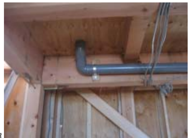
WC2の排水管
