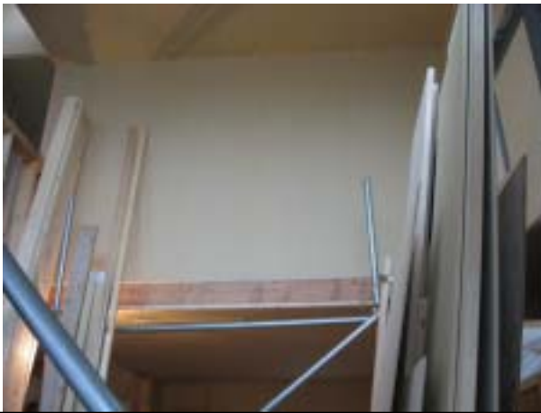
左/ リビング吹抜 右/ キッチン
