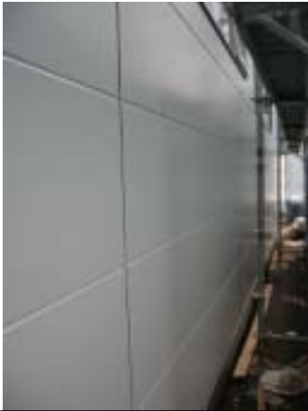
左/西側外壁 中/北側見下し 右/北側外壁
