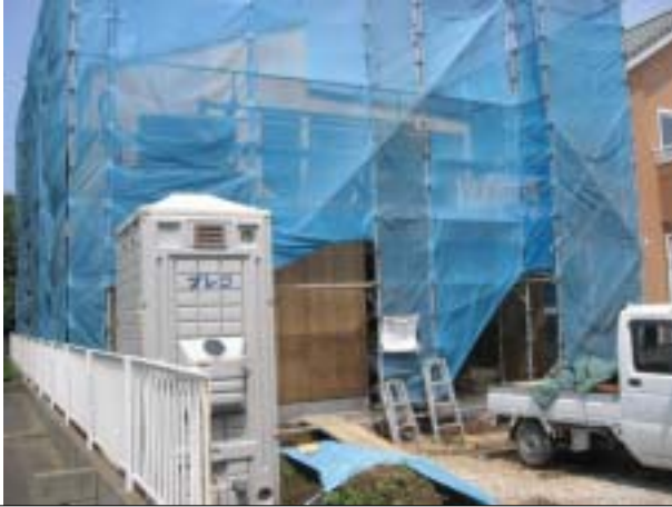
左/外部 右/内部
