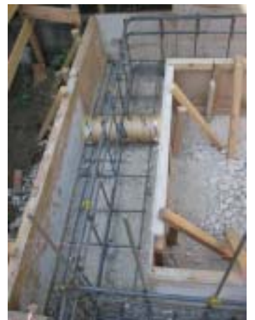
坪庭基礎 給排水スリーブ
